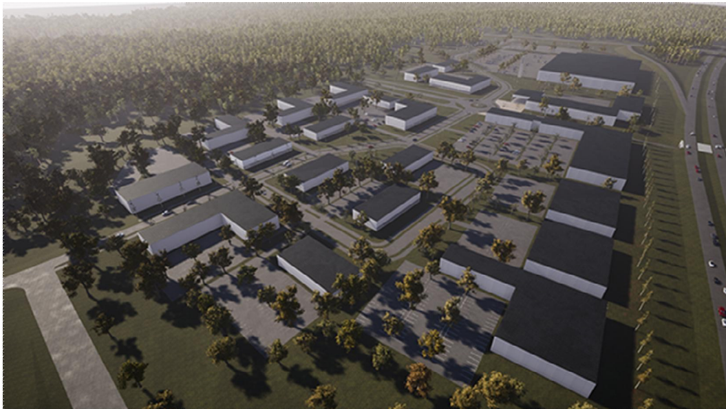
Kuva 25. Näkymä poh- joiseen.
